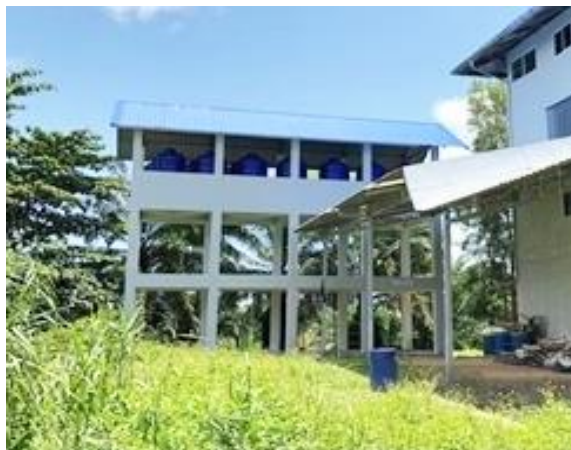
雨水貯留施設
