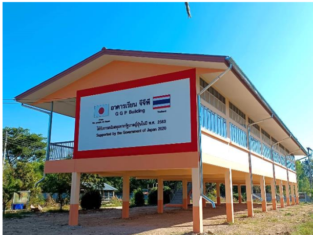
อาคารเรียนใหม่ที่ก่อสร้างเสร็จ
