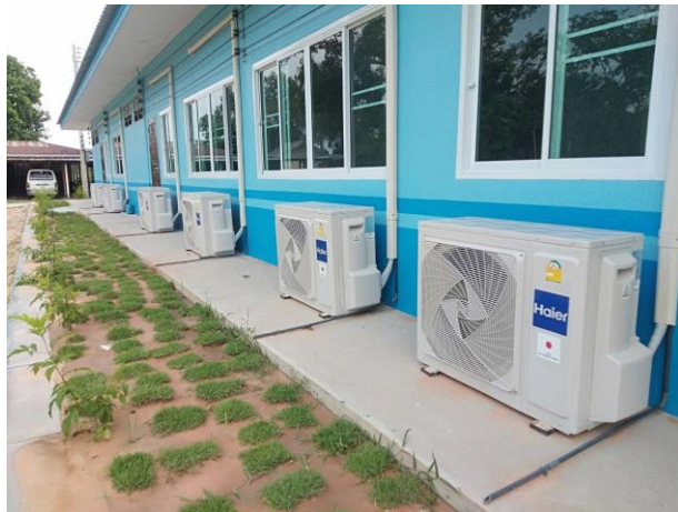
竣工した新校舎(背面)
