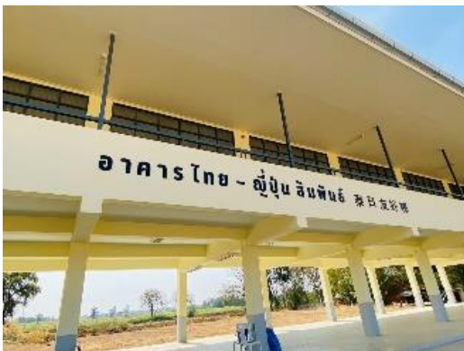
อาคารเรียนใหม่
