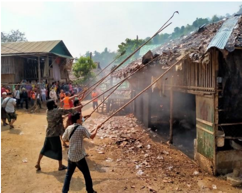
บ้านที่ถูกรื้อถอนเพื่อป้องกันการลุกลามของเพลิง ในเหตุเพลิงไหม้
