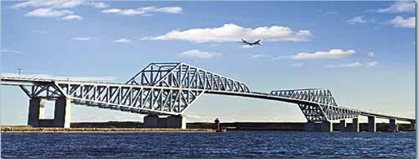
Tokyo Gate Bridge : เหล็กประเภท SBHS สำหรับการสร้างสะพาน
